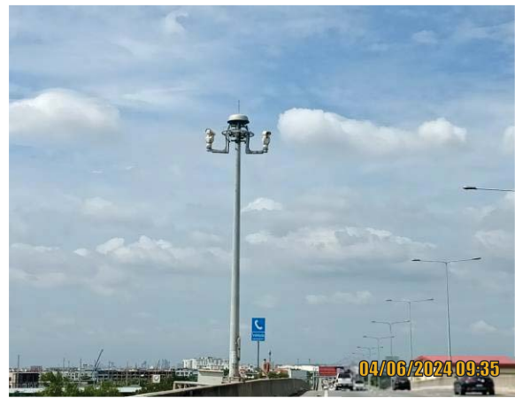
รูปที่ 3.2-8 กล้องโทรทัศน์วงจรปิดดูสภาพจราจร
